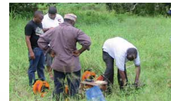
Fasi del progetto sostenuto da SOS Bambino: studio del sito, scavo del pozzo e impianto eolico.
